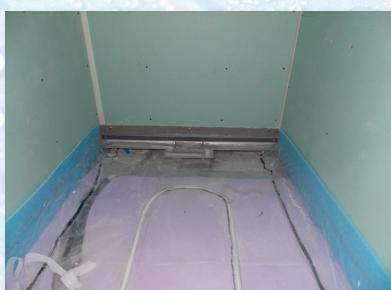
Wandschlitzrinne mit Montagefüsse und Wandschrauben genau horizontal und vertikal montieren.
