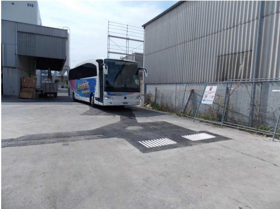
Darüber fahren, Fäkalientank entleeren
